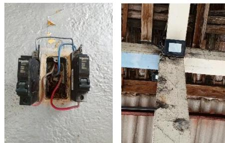
Imagen 36. Breaker y reflector en mal estado
