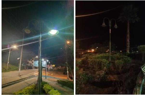
Imagen 10. Lámparas existentes en mal estado
