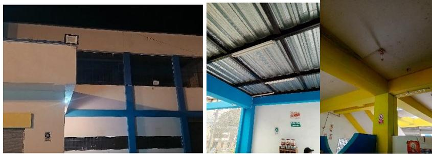
Imagen 23. Reflectores en mal estado
