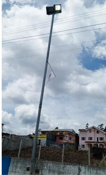
*Imagen 29. Reflector en mal estado*
